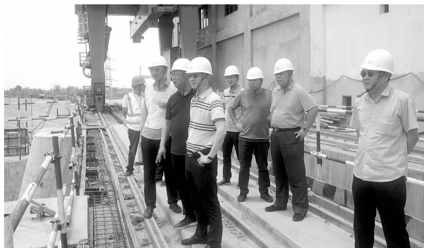
查看各工点施工情况
