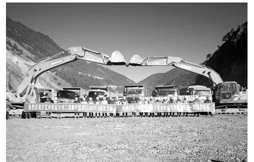
完成填筑目标 熊闯 摄
