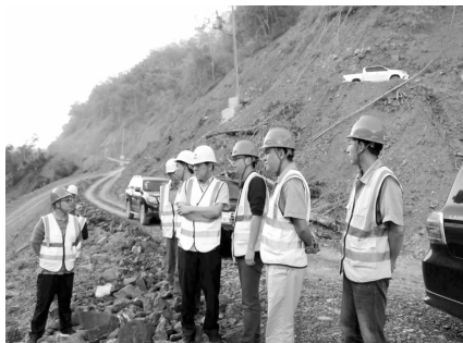
余明川副总经理产看施工现场 刘建伟 摄
